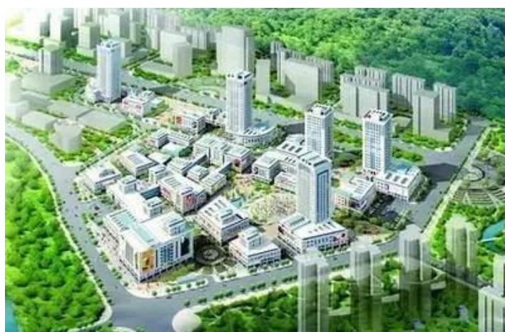
延安大学新校区（建设中）
